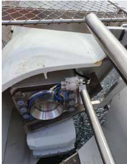
Sockets in tegenoverliggende sectie waarmee Moment Connectie afgemaakt kan worden.
