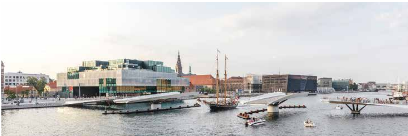
Twee horizontaal draaiende brugdelen voor een ruime doorgang van het scheepvaartverkeer.
