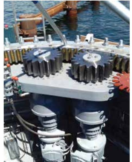
Laatste blik op de aandrijving voordat de brugsecties op de pijlers geplaatst worden.
