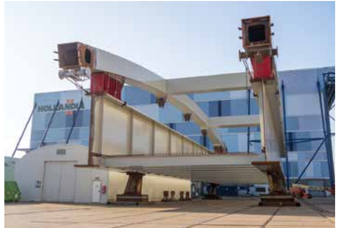
Sectie 3 met boogdeel gereed voor transport naar voorbouwlocatie.
