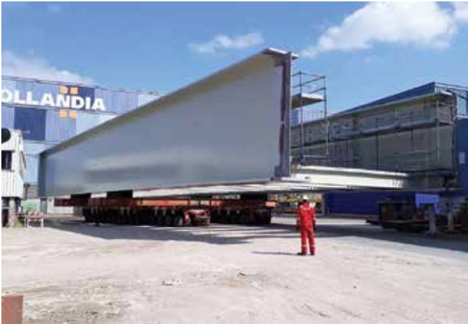
Aanbrug sectie 5 rijdt conserveerhal uit.
