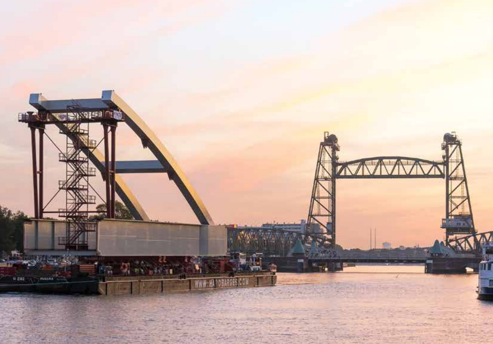
Transport brugdek met boogdeel vanuit Krimpen aan den IJssel door Rotterdam naar Rozenburg.
