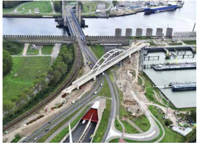
Brug op eindpositie boven de Thomassentunnel.
