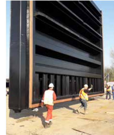
De montageploeg plaatst één van de deuren van de Reeve-Schutsluis.
