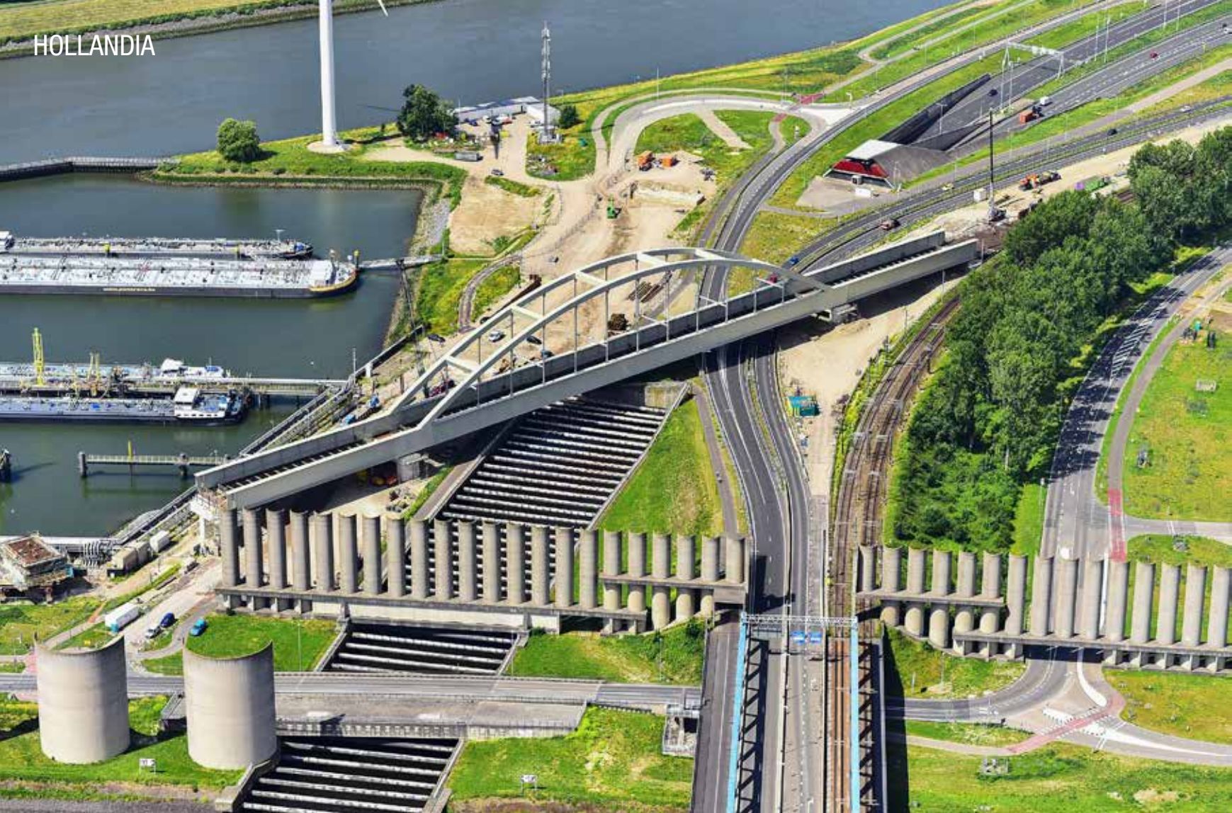
Spoorbrug boven de Thomassentunnel in het Theemswegtracé, (Beeld: Havenbedrijf Rotterdam, Aeroview/PortPictures).
