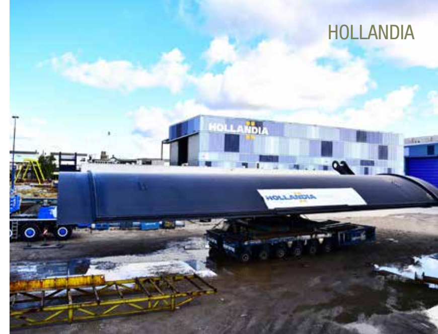
Segmentdeur voor stormvloedkering Boston Barrier in de U.K. klaar om op transport te gaan, (Beeld: PortPictures).
