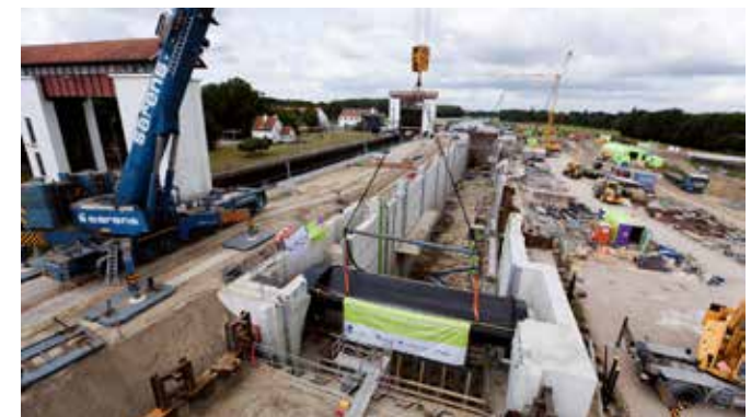
Realisatie segmentdeur en puntdeuren voor nieuwe Noordersluis Eefde, (Beeld: Bouwfotografie).
